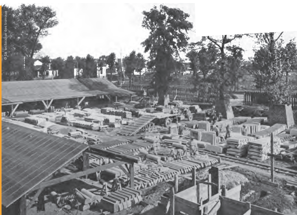
Vue du chantier de préfabrication des éléments moulés pour toutes les baies de construction.
